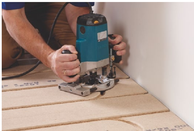
Rysunek 7 Wycinanie rowków obrotowych w co 2. rzędzie.
