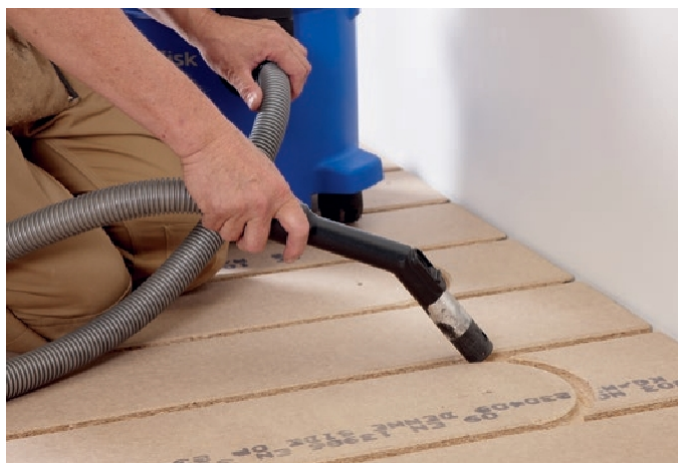
Rysunek 8 Staranne czyszczenie zapobiega odgłosom skrzypienia.
