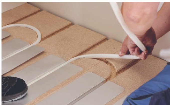
Rysunek 10 Montaż rury grzewczej.
