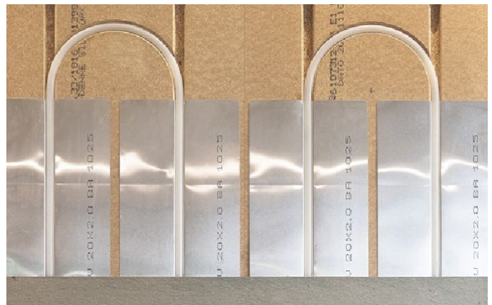
Rysunek 3 Płyty emitujące ciepło dla rur grzewczych 16 mm, rozstaw rowków 200 mm cc.
